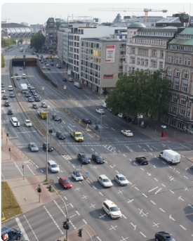
Der LSBG teilte die Fahrstreifen an der Kreuzung Ferdinandstor neu auf und verbesserte die Abbiegemöglichkeiten.
